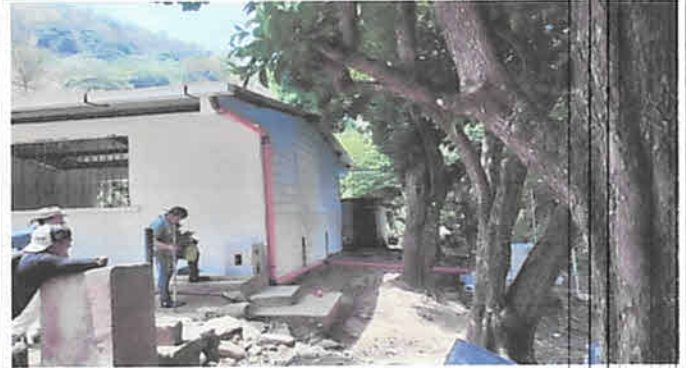
Foto 2: Colocación de canales
