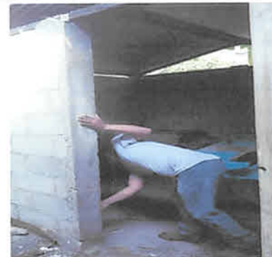
Foto 4: Reparación de Cocina
