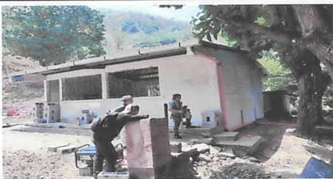
Foto 3: Colocación de malla
